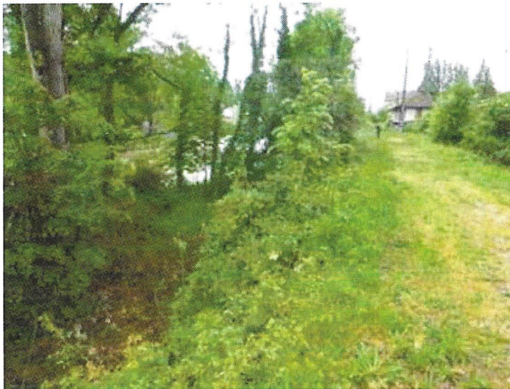
2 : VUE DE LA DIGUE ET DE LA RISBERME EXISTANTE
